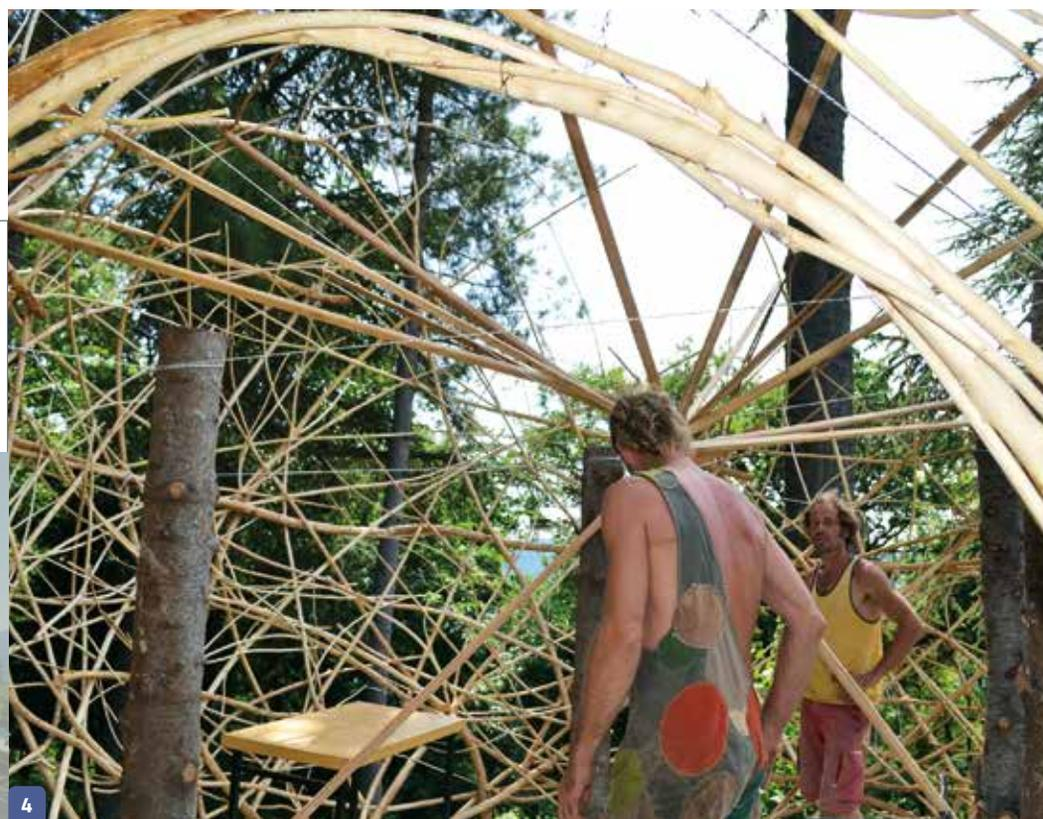
support durant la construction et qu'on retire une fois la boule achevée. Le trépied doit arriver à la hauteur du centre de cette sphère (photo 3). Par exemple, si la boule vannée mesure 5 m de diamètre, le plancher aura également un diamètre de 5 m. Le sommet du trépied – qui matérialise le centre de la sphère – se trouvera à 2,50 m de hauteur et servira de support au cercle principal. Le cercle d'entrée sera fixé au plancher, sur le cercle principal, puis sur les autres branches.
